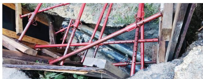
Un puisard est réalisé pour éliminer les eaux d'infiltration sous la chaufferie avec une pompe de relevage.
