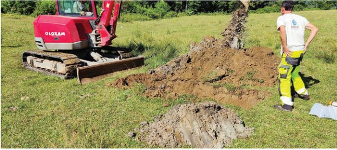
Station d'épuration de la Mazaurie : sondage et essais géotechniques
