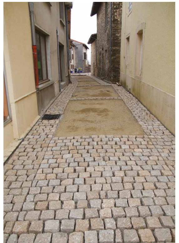
Réfection ruelle traversière
